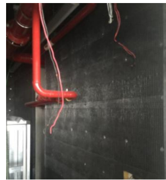
งานติดตั้งระบบห้องกันเสียง
