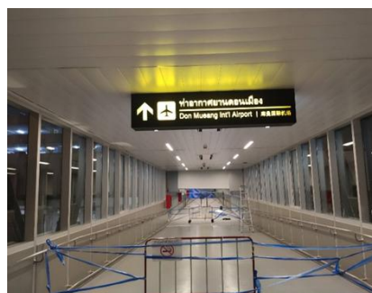
งานติดตั้งป้ายไฟออกทาง
