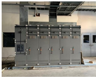
งานติดตั้งระบบตู้ไฟฟ้าแรงดันต่ำ (400โวลท์)
