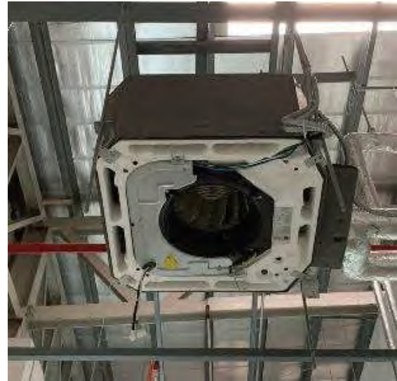
งานติดตั้งเครื่องส่งลมขนาดเล็ก
