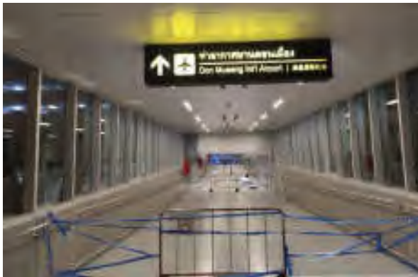
งานติดตั้งป้ายไฟบอกทาง
