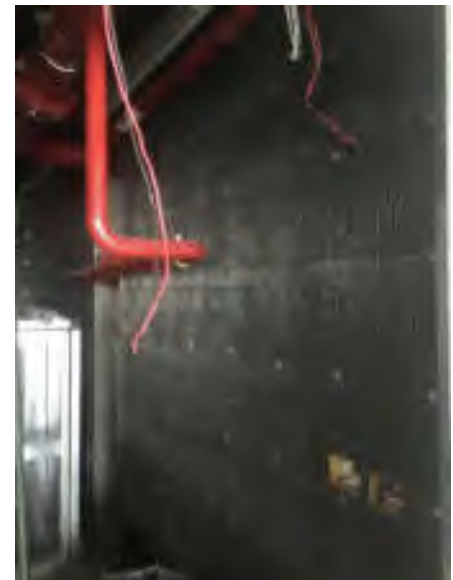
งานติดตั้งระบบห้องกันเสียง
