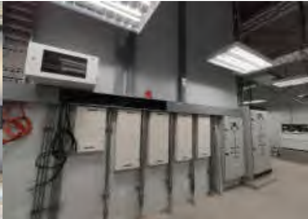
งานติดตั้งตู้ไฟฟ้าคอนโทรล
