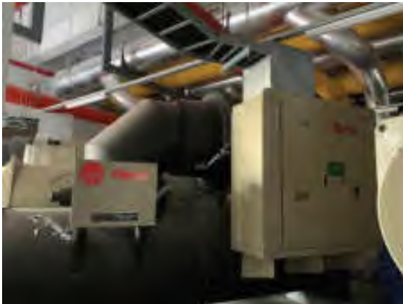
งานติดตั้งปรับอากาศขนาดใหญ่ (Chiller)
