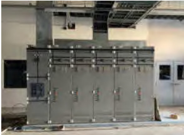
งานติดตั้งระบบตู้ไฟฟ้าแรงดันต่ำ (400 โวลท์)
