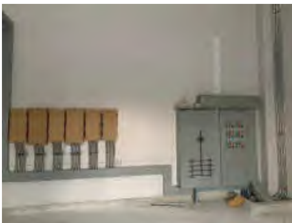
งานติดตั้งตู้ควบคุมระบบบิมน้ำ
