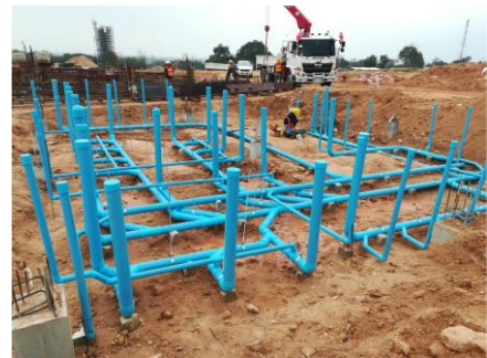
งานติดตั้งระบบระบายน้ำเสีย
