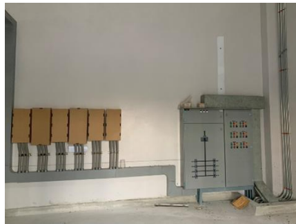
งานติดตั้งตู้ควบคุมระบบปั๊มน้ำ
