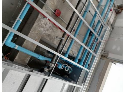
งานติดตั้งระบบท่อน้ำประปาในอาคาร
