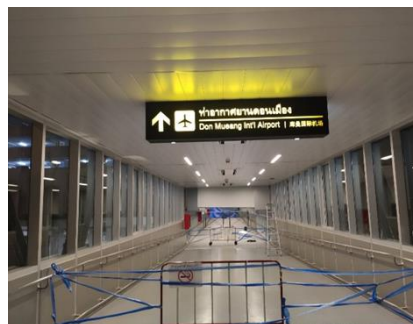
งานติดตั้งป้ายไฟบอกทาง
