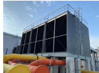
งานติดตั้งหอผึ่งเย็น (Cooling Tower)
