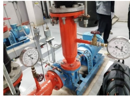
งานติดตั้งระบบปั้มน้ำ (Pumping)
