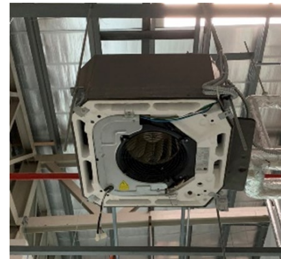
งานติดตั้งเครื่องส่งลมขนาดเล็ก
